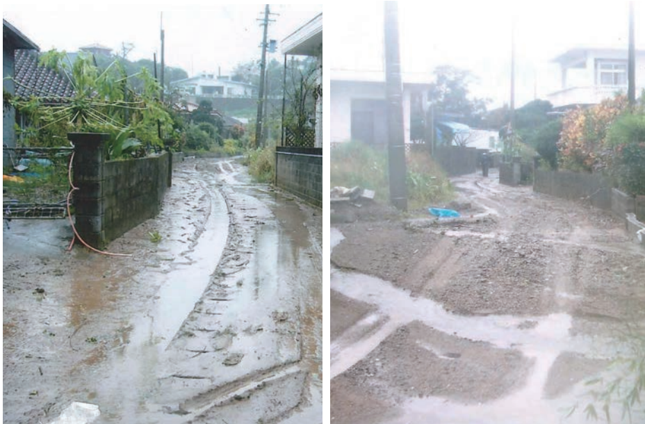
土砂が堆積する奥間区集落道、排水施設
