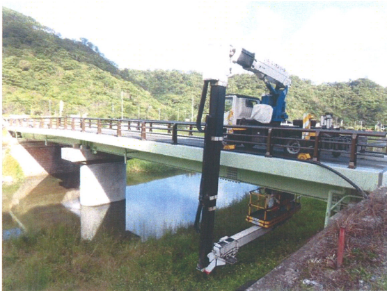
写真-2 定期点検状況
