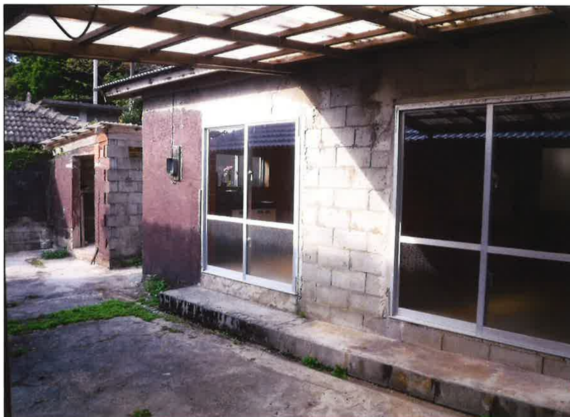
外観(屋敷裏倉庫等)
