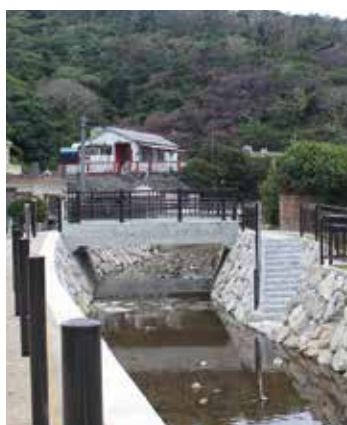
完成した河川に降りられる階段
