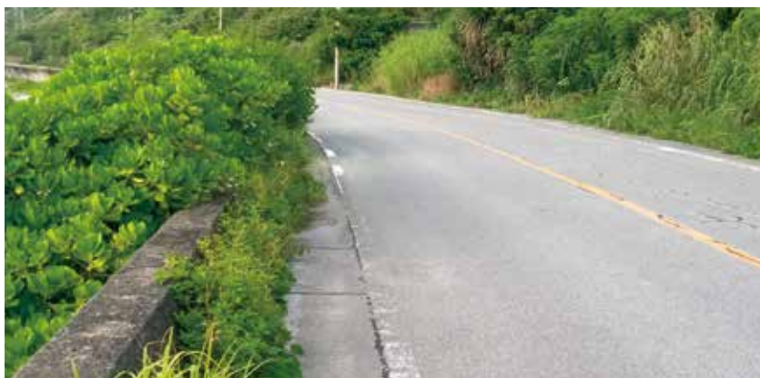
宇嘉未整備区間
