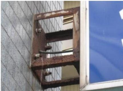
ブラケット・取付部の腐食
