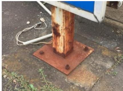
支柱根元の腐食、支柱と基礎部分・根巻きに生じた隙間、支柱ぐらつき
