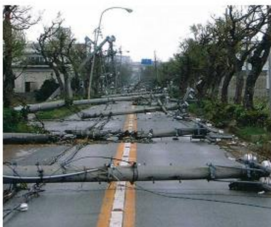
写真－1 台風による電柱倒壊状況
