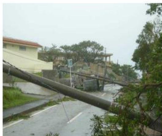
写真－1 台風による電柱倒壊状況
